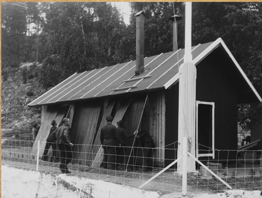
Mannskapet fra Fram monterer Framheim i hagen til Amundsens på Svartskog.
